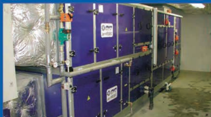
Бассейн в г. Богунёвице Вентиляционная установка для бассейнов H/HL, общей мощности 9.000 м3/час
