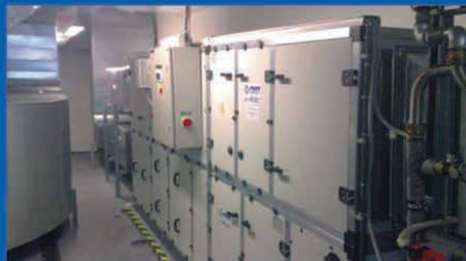
Аквапарк в г. Валашке Мезиржичи Вентиляционные установки для бассейнов H/HL, (3 установки) общей мощности прил. 53.500 м3/час.
