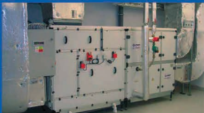
Санаторий в г. Збуж Вентиляционная установка для бассейнов H/HL, общей мощности 3.000 м3/час
