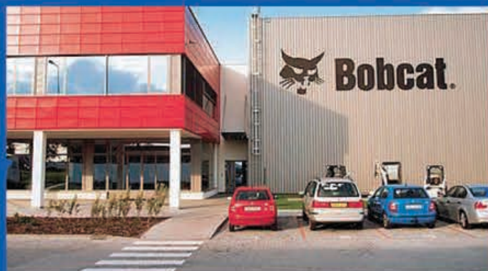
Bobcat Dobříš (г. Добржиш) Вентиляционные установки серии H/NL (15 установок) наружное исполнение общей мощности прил. 421.900 м³/час
