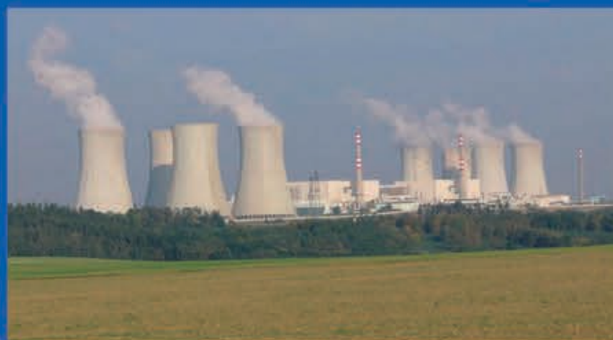
Атомная электростанция Дукованы Вентиляционные установки серии H/NL (5 установок) сейсмостойкое исполнение общей мощности 5.000 – 8.000 м³/час
