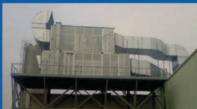
Coca & Cola, Украина Вентиляционная установка серии H/NL общей мощности 80.000 м³/час
