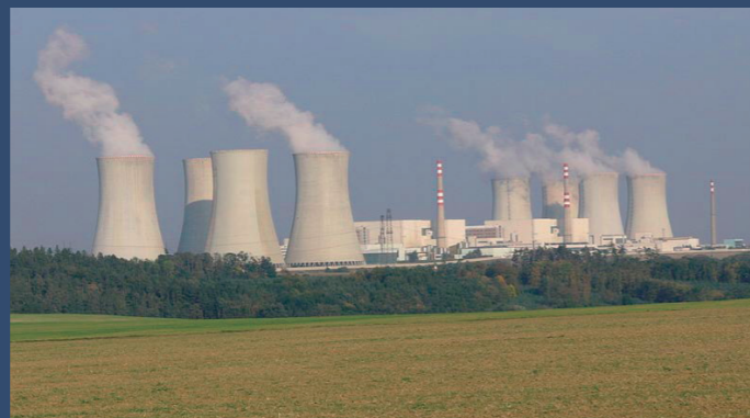
Атомная электростанция Дукованы
